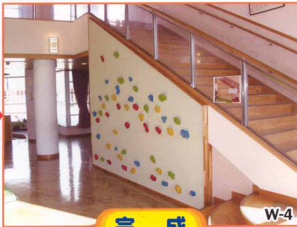
京都市内 佛教大学付属幼稚園 (幅 3.5m × 高さ 3.2m) RC に木下地取付け
