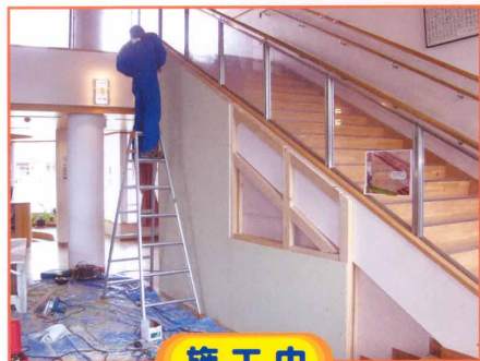
京都市内 佛教大学付属幼稚園 (幅 3.5m × 高さ 3.2m) RC に木下地取付け
