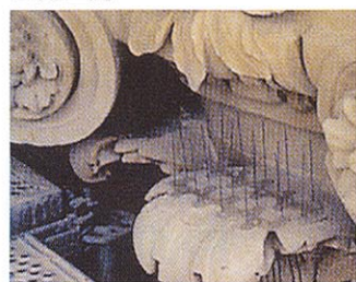
▲鳥の隙間への進入を防ぎます。
